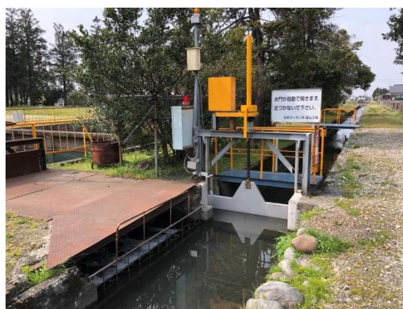
最終沈殿槽のゲート
